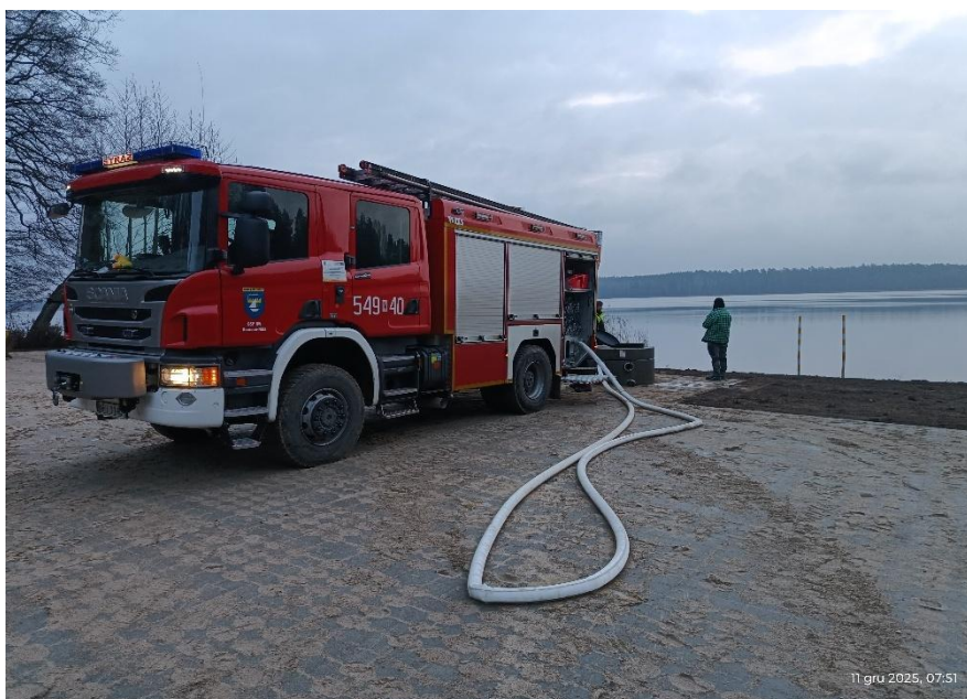
Ryc. 8 Zmodernizowany punkt czerpania wody
